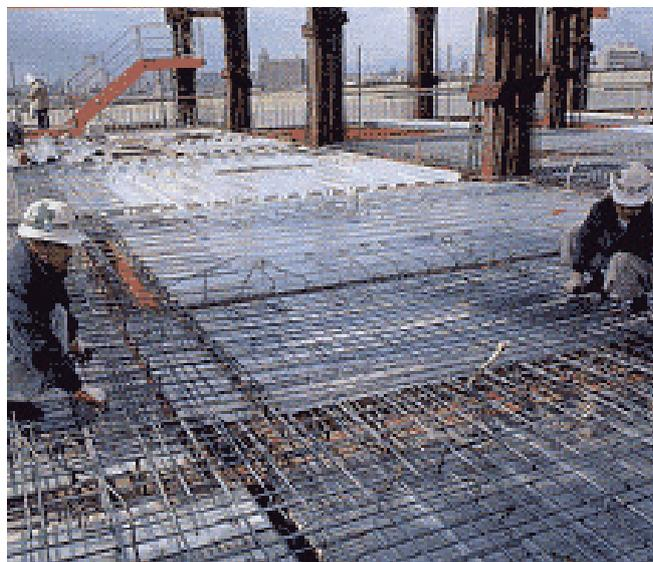
トーアミCDメッシュは、JIS G 3532鉄線に規定された異形鉄線を使用した溶接金網です。溶接点のせん断強さや溶接点を含む機械的性質を、JIS G 3551溶接金網の規定より高度な保証内容とし、これにより突き出し部延長筋及び添え筋での継ぎ手・定着を可能としました。また、トーアミCDメッシュを用いた合成スラブでは、重ね継手の有無にかかわらず**2時間の耐火性能**を有することが証明されています。
