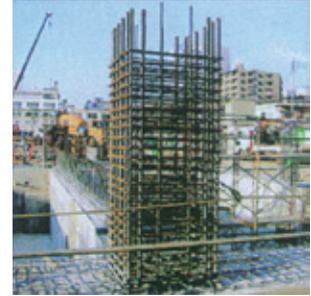
[溶接閉鎖形を柱に仕様した配筋例]
